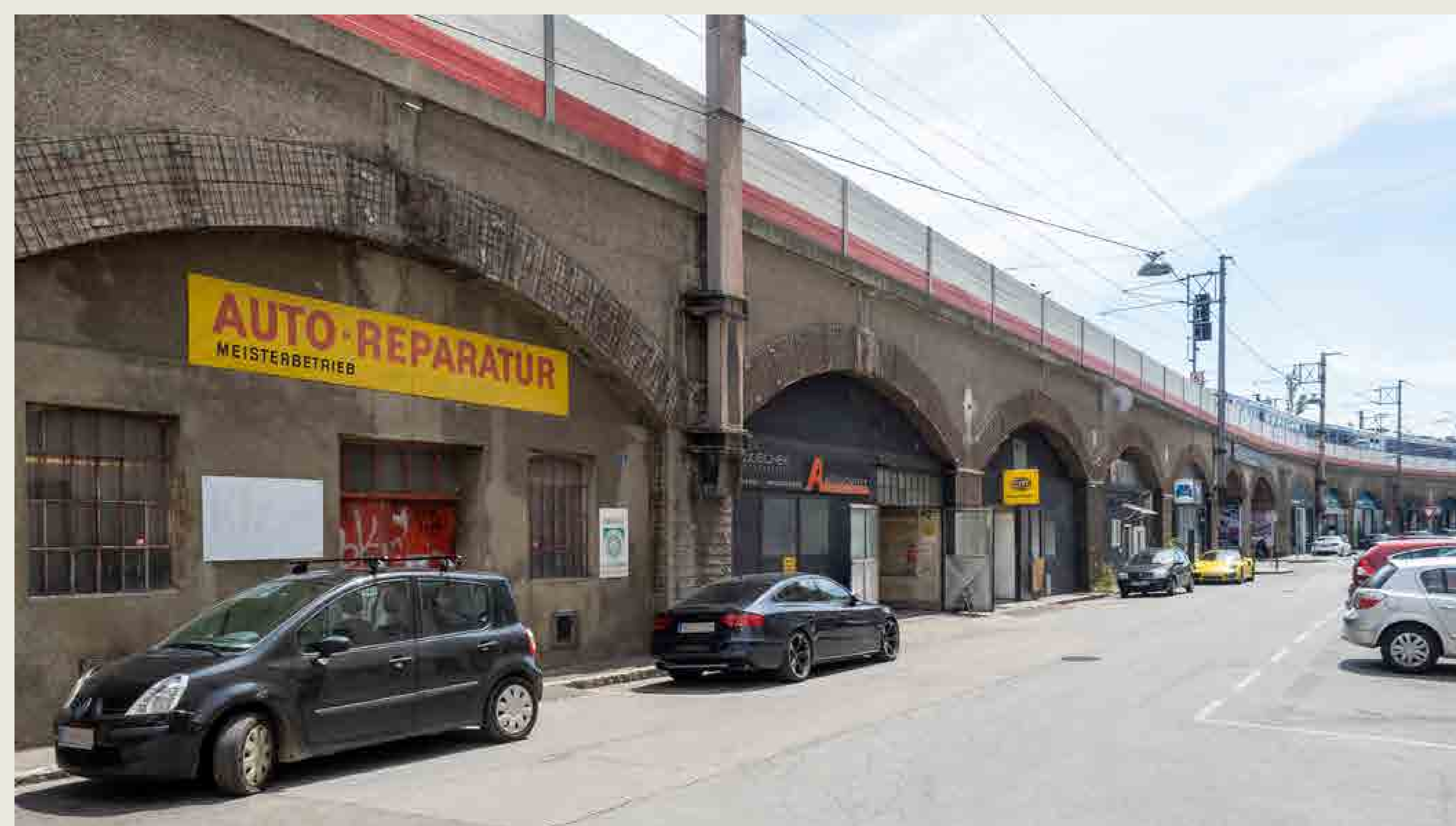
Bestehende Viaduktbögen unter der Bahnstrecke (© ÖBB/Herzog)
