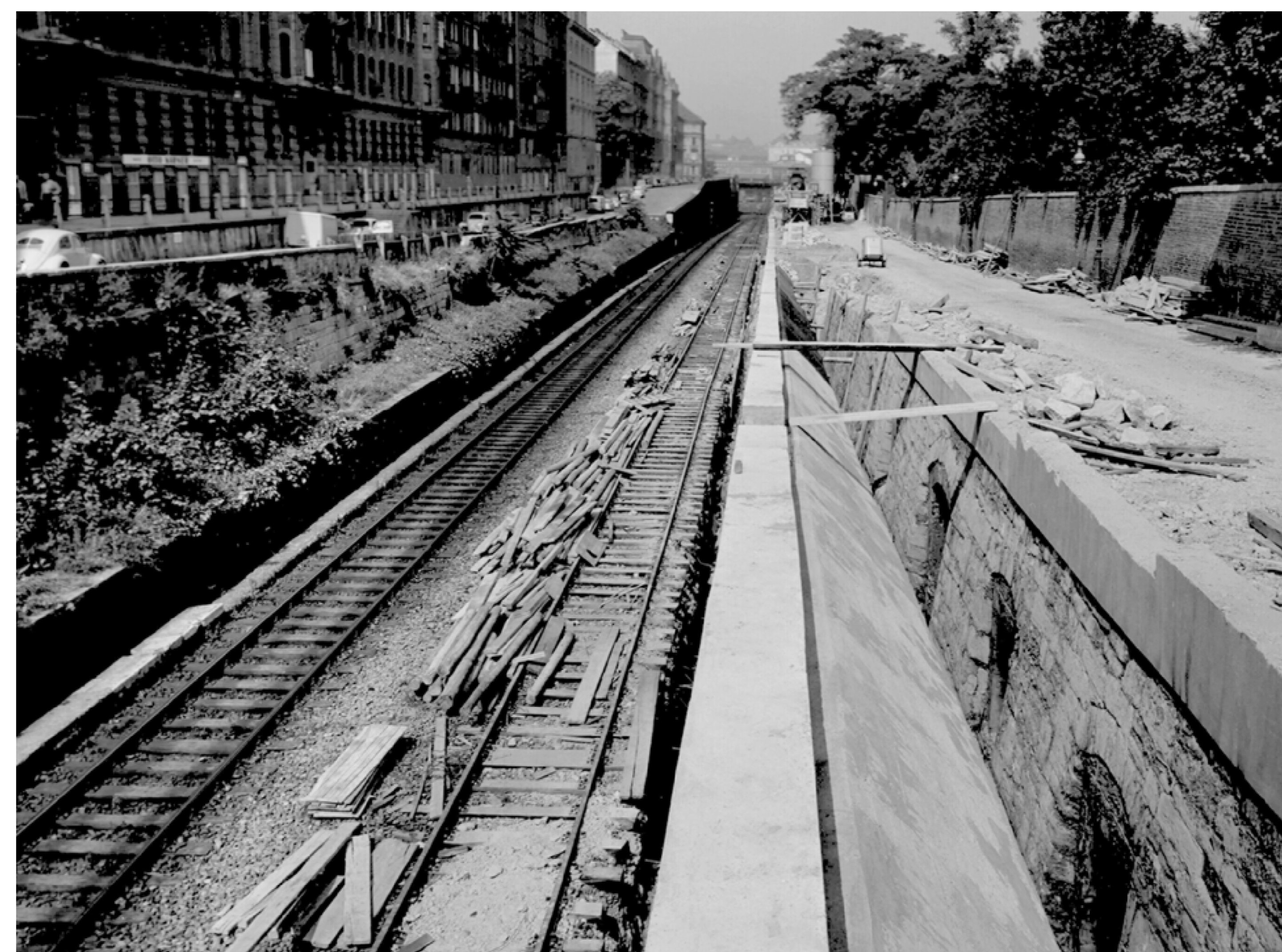
Bauarbeiten im Bereich der Einschnittsmauern (© ÖBB Archiv)
