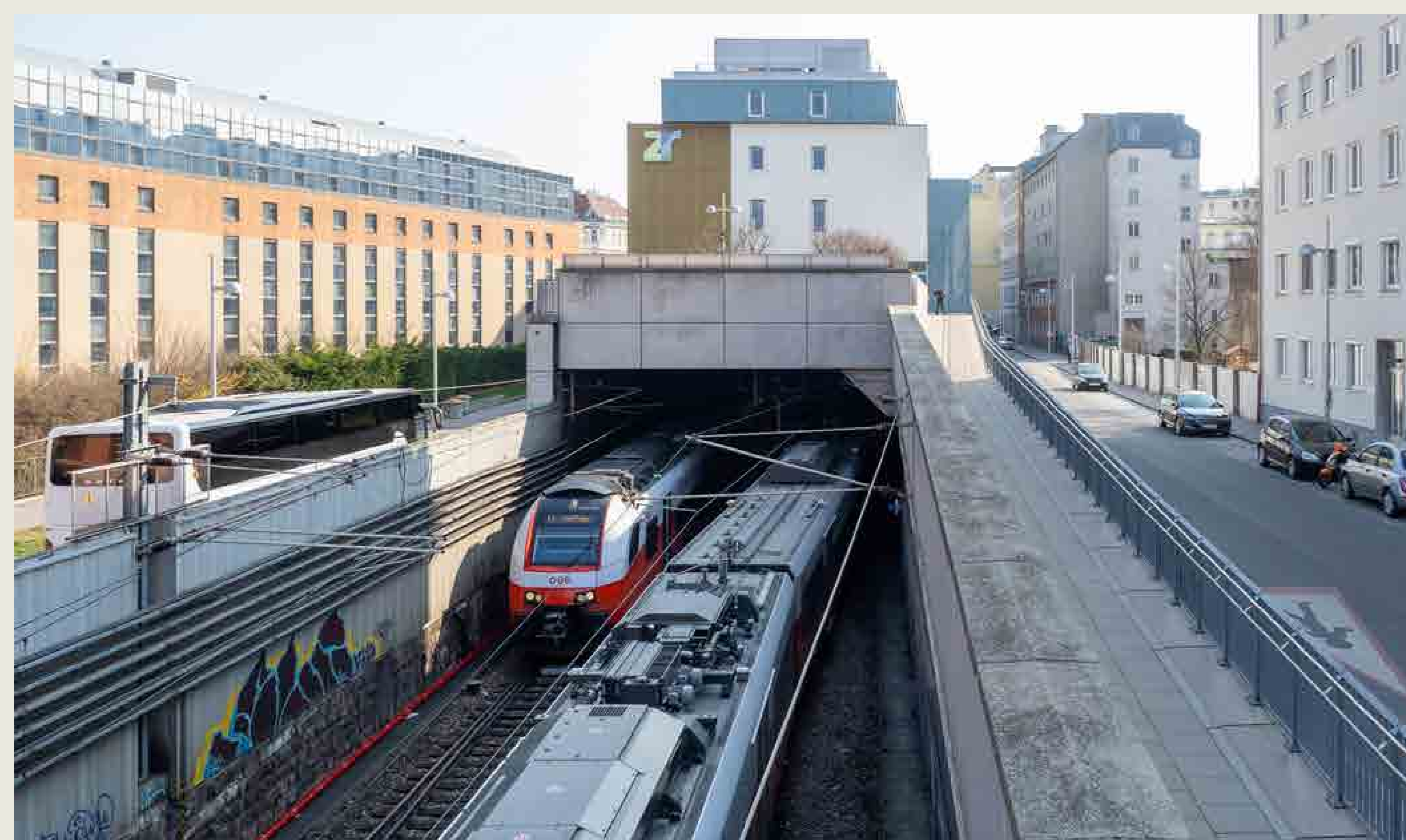
Haltestelle Rennweg im Bestand (© ÖBB/Herzog)
